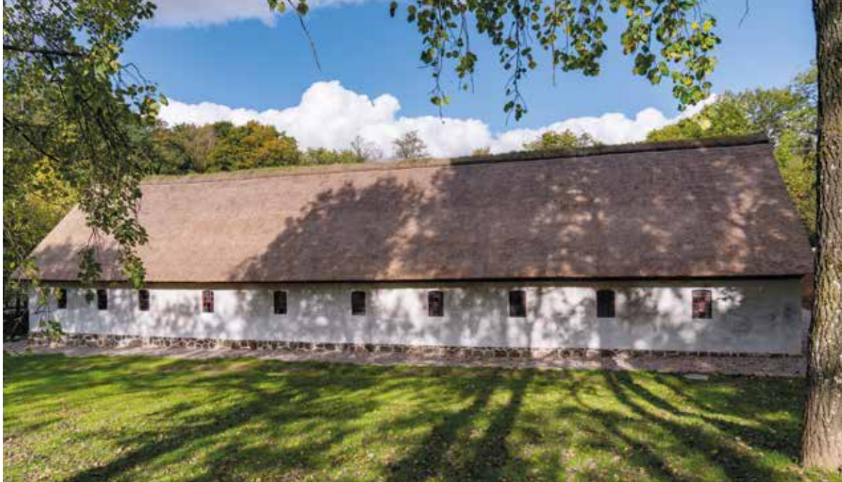
Sydlængen er opført i 1897 som erstatning for en tidligere bindingsværksbygning. Bygningen er fuldmuret og blev bl.a. brugt som stald til kvæg, svin og får.
