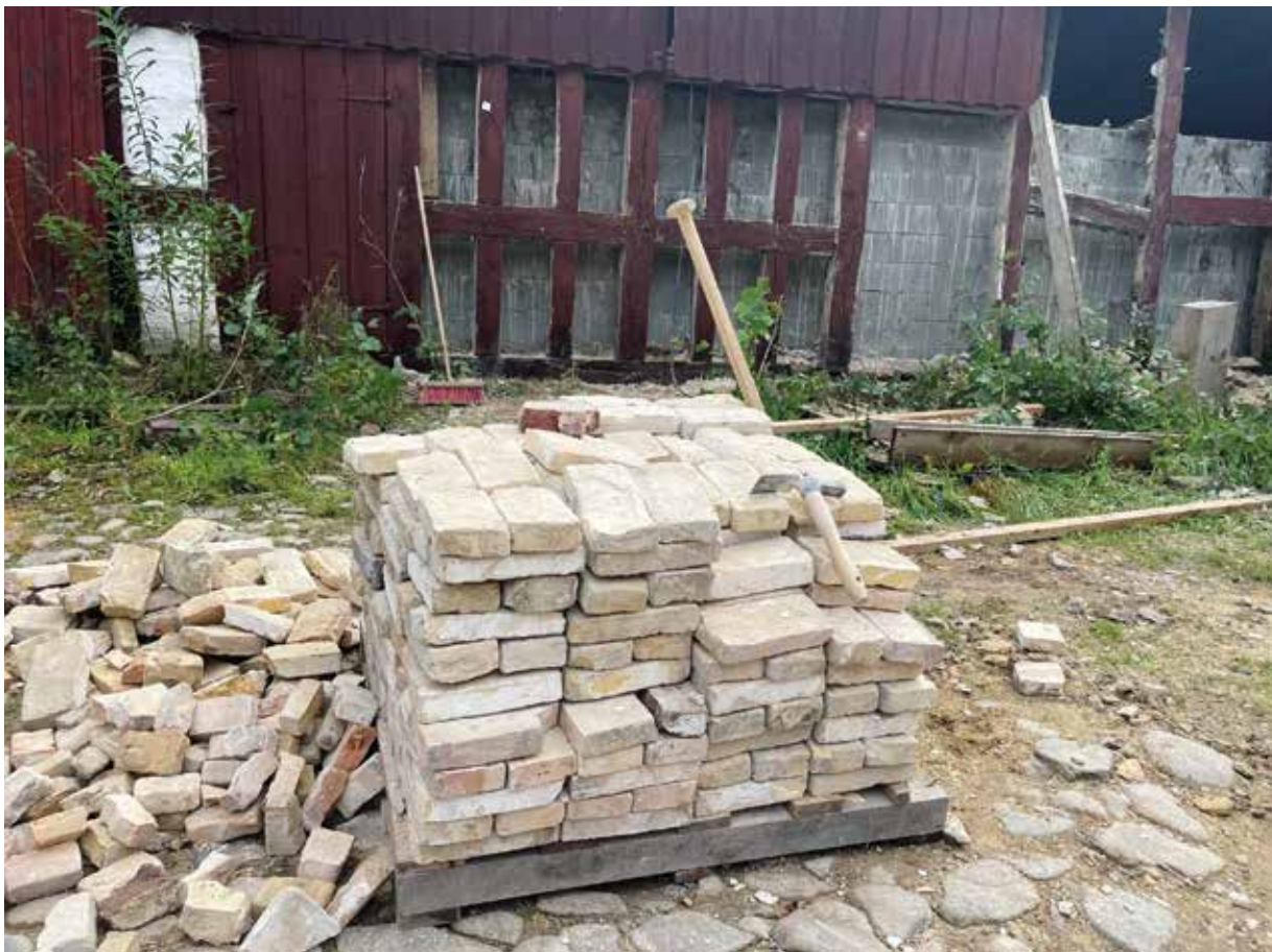
På bindingsværkslængerne er de dele af egetræet, som kunne bevares, blevet udluset, dvs. forsynet med nye stykker af træ, hvor de oprindelige var rådnet. Tavlene er muret om.
