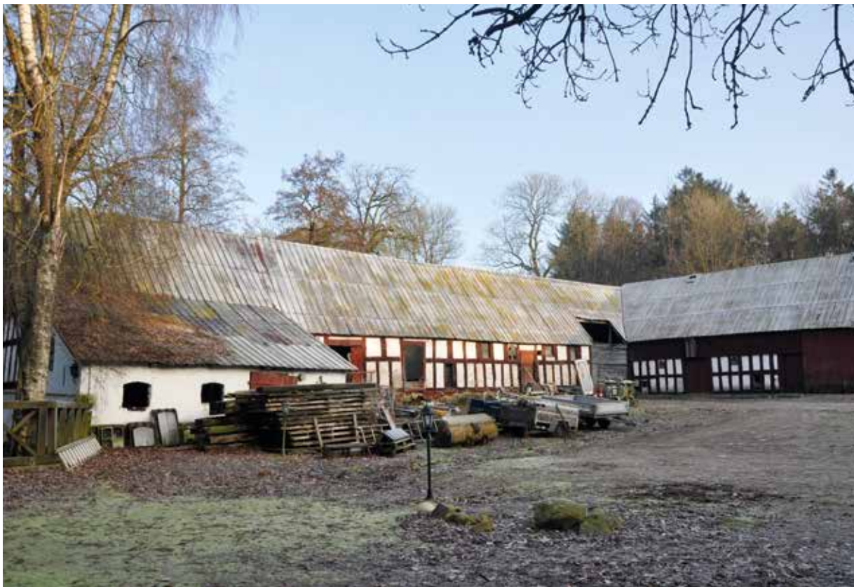
Nordlængen er opført i 1784 og senere forlænget. I 1800-tallet blev længen forsynet med en muret tilbygning, et såkaldt udskud.
