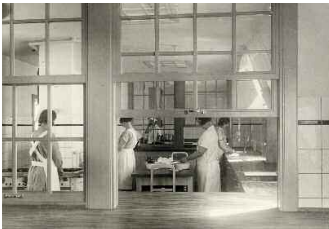
Det tidligere køkken på anden sal i husets sydvestlige hjørne.
