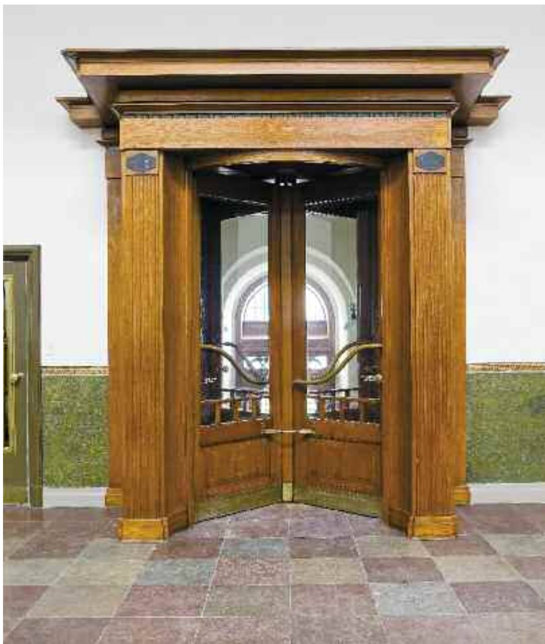
Den imponerende svingdør, der forbinder centralrummet med vindfanget og hoveddøren.
