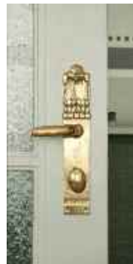
Et af husets originale dørhåndtag. Mange steder er de med tiden blevet fjernet. Under restaureringen blev de uoriginale dørhåndtag fjernet og erstattet med nye kopier af de originale.
