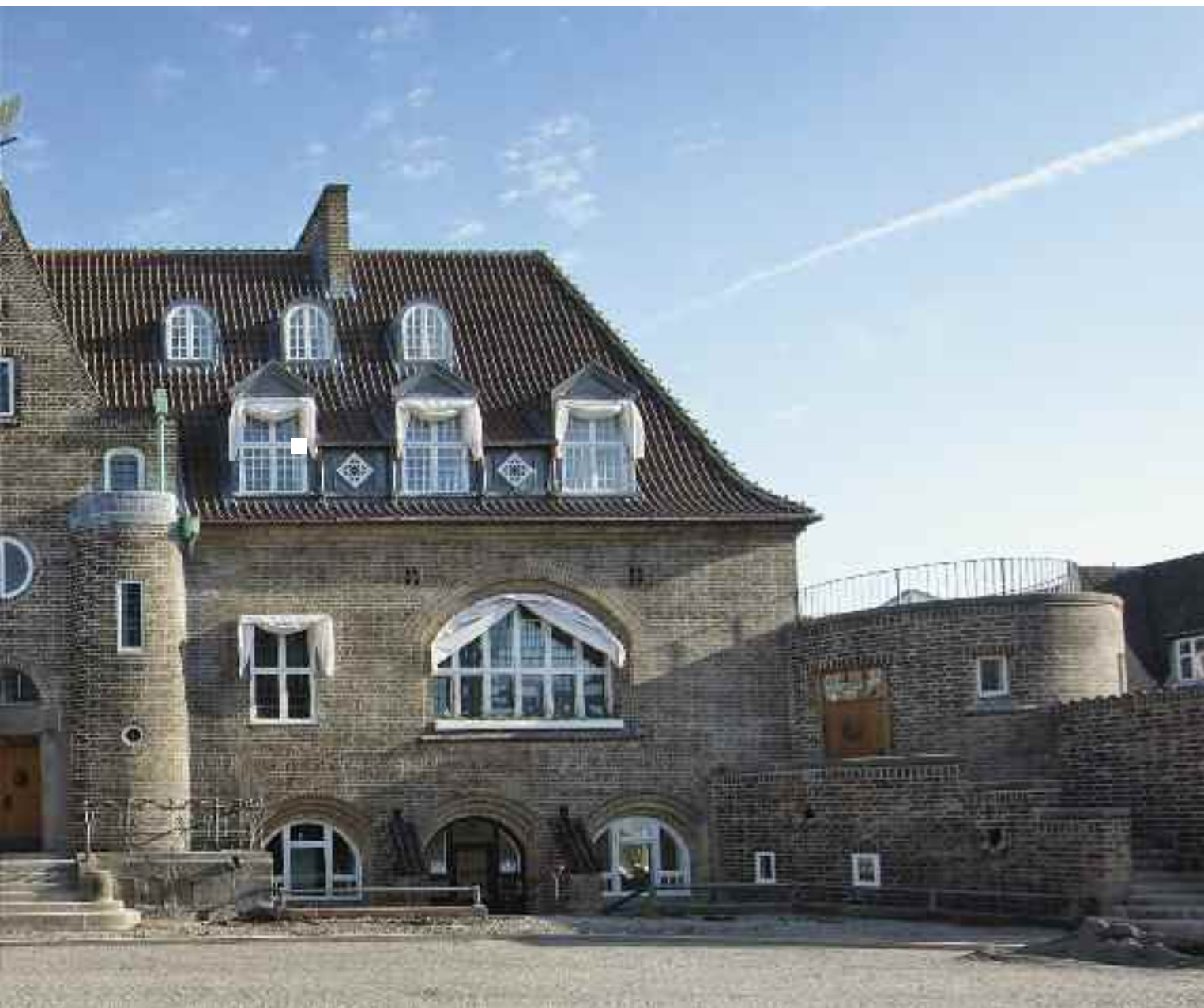
Sydfacaden efter restaureringen.
