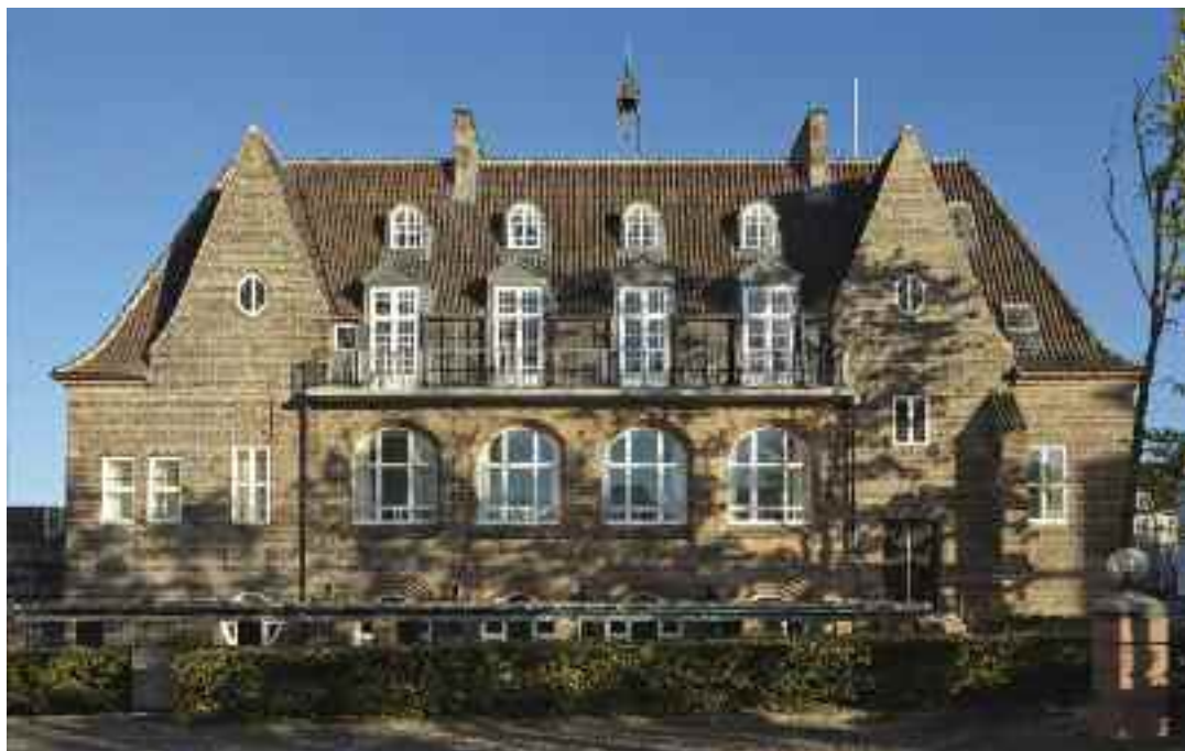
Nordfacaden – hvor der før restaureringen i 2008 stod en række seksåede træer, der nu er fjernet, så facaden igen med værdighed åbner mod nord.
