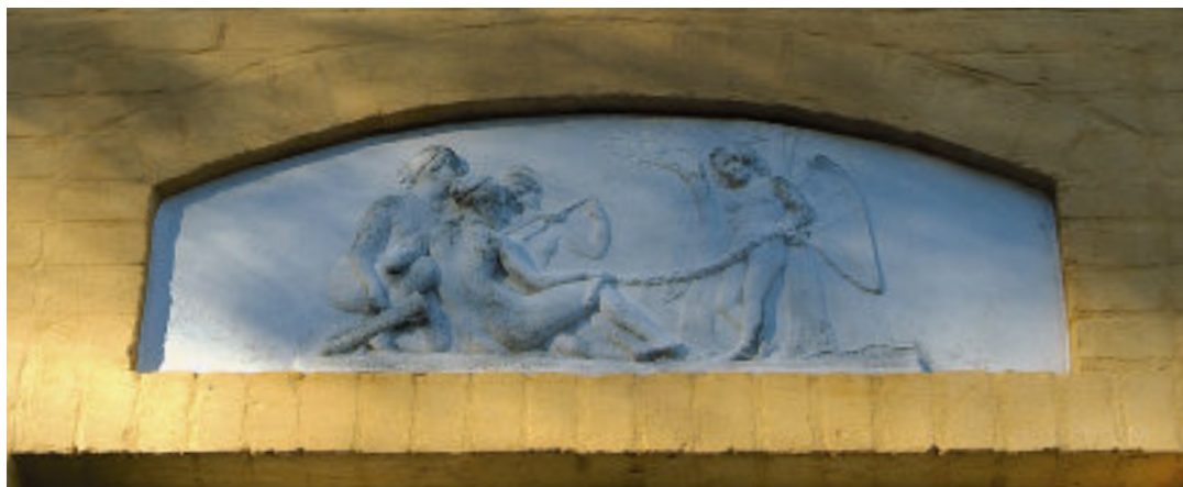
Gipsrelieffet over hoveddøren, "Amor bunden hos gratierne", efter Thorvaldsens original var så medtaget af vind og vejr, at der under restaureringen i 1979 måtte fremstilles nye gipsafstøbninger.
