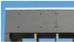
FACADEPLADER AF PRESSEDREJSEGENBRUGS-PAPIR (RICHLITE)
