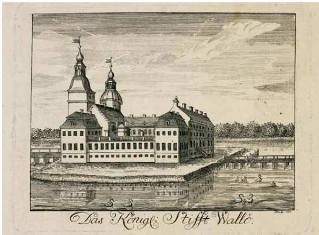
Laurids de Thurahs stiftsbygning til Vallø Adelige Frøkenkloster, opført 1736. Det Harboeske Enkefruekloster blev ombygget efter samme skema, og flere bygningsdetaller på den egentlige facade inde i slotsgården går igen på facaden i Stormgade.
