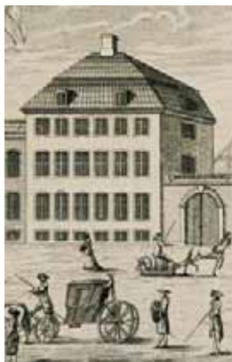
Bindingsværksgavlen på den 19 m lange køkkenbygning kunne ses fra gaden. Den stod i 250 år, men blev meget forkortet ved en ombygning i 1875 for at få lys ind i de nye værelser bag porten.
