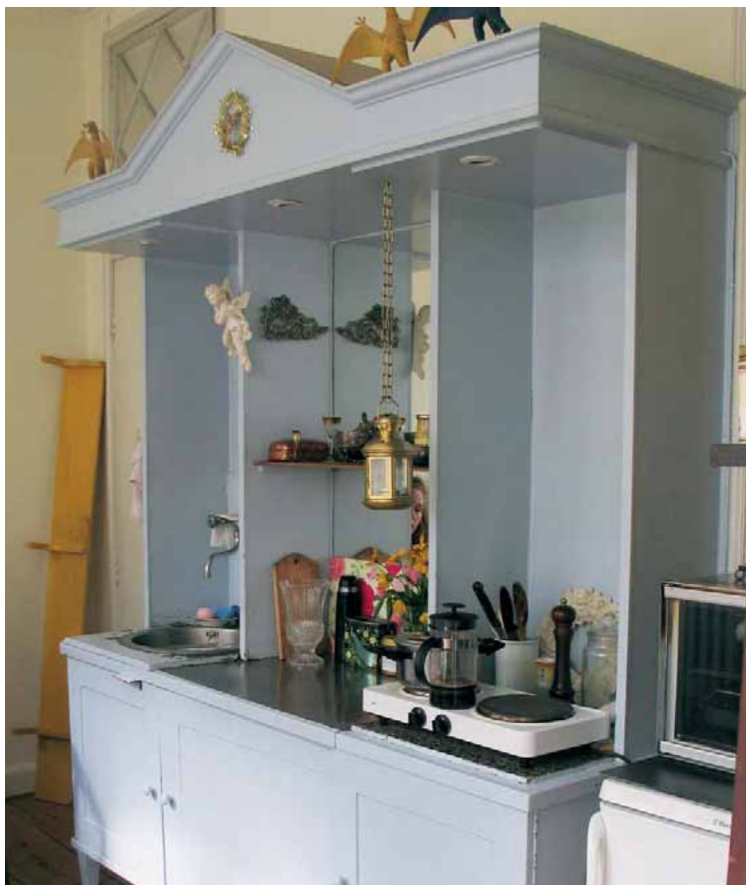
Arkitekten Aage Rafns køkkenmodul med gasblus, en lille vask og terrazzobordplade – der var endnu bevaret et enkelt, da Realea A/S begyndte renoveringen i 2006
