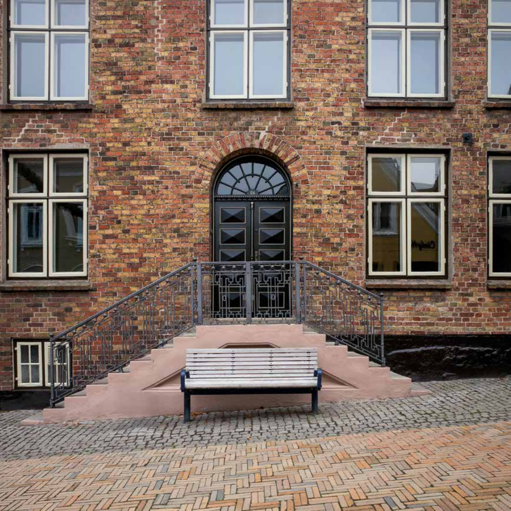
En muret toløbstrappe med granittrin og smedejernsrækværk i Louis Seize-stil fører fra gågaden op til forhusets hoveddør.
