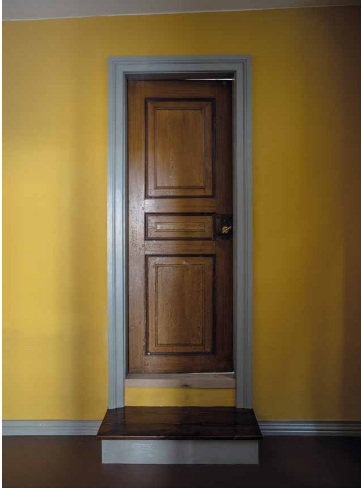
Døren med ådring er restaureret, og den gule farve er valgt med inspiration fra de malingslag, som farvearkæologer fandt på væggene.
