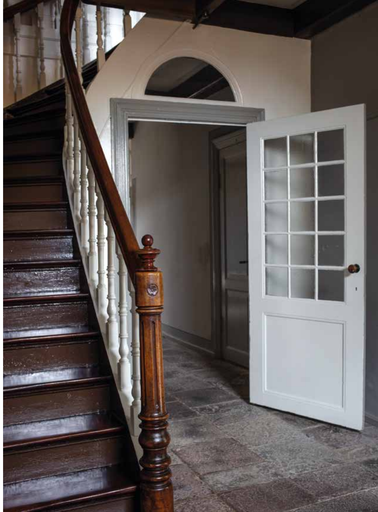
I forhusets gennemgående trapperum, dielen, ligger stadig belægningen med ølandsfliser, som stammer fra første halvdel af 1800-tallet.
