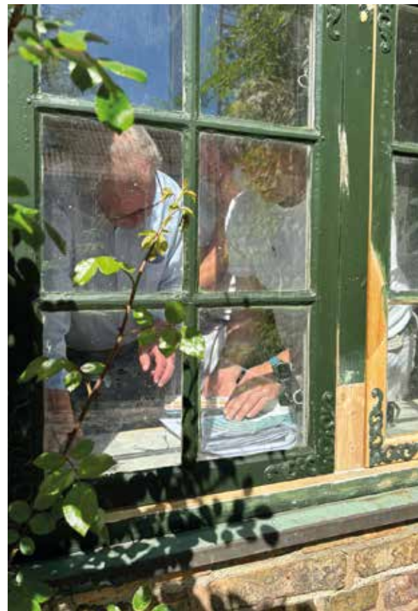
Under restaureringen blev der via store plancher holdt godt øje med de valgte farver på både vægge og træværk.
