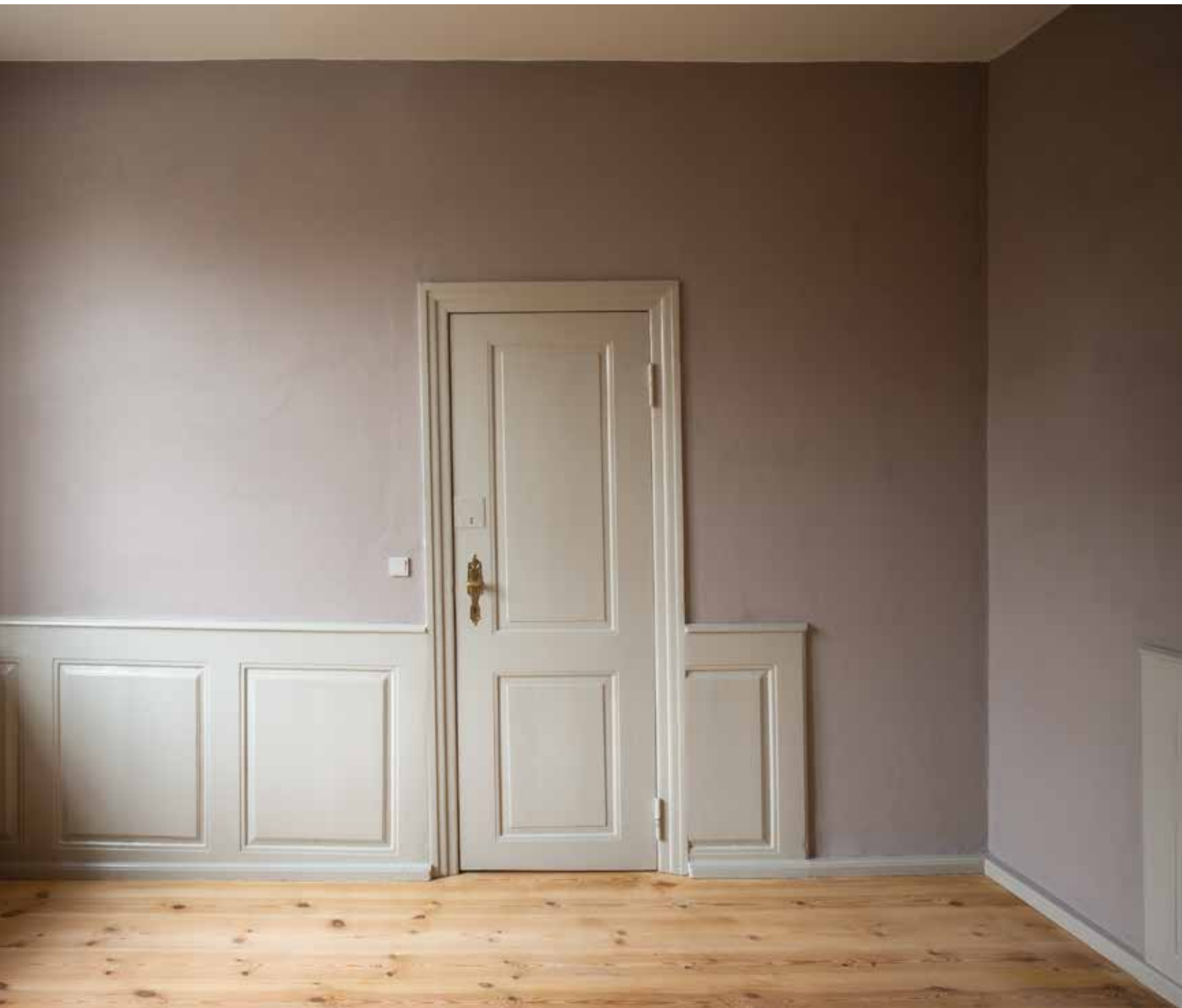
Under restaureringen af Marcussens Gård er alt træværk i forhuset og det første sidehus sat i stand og malet.
