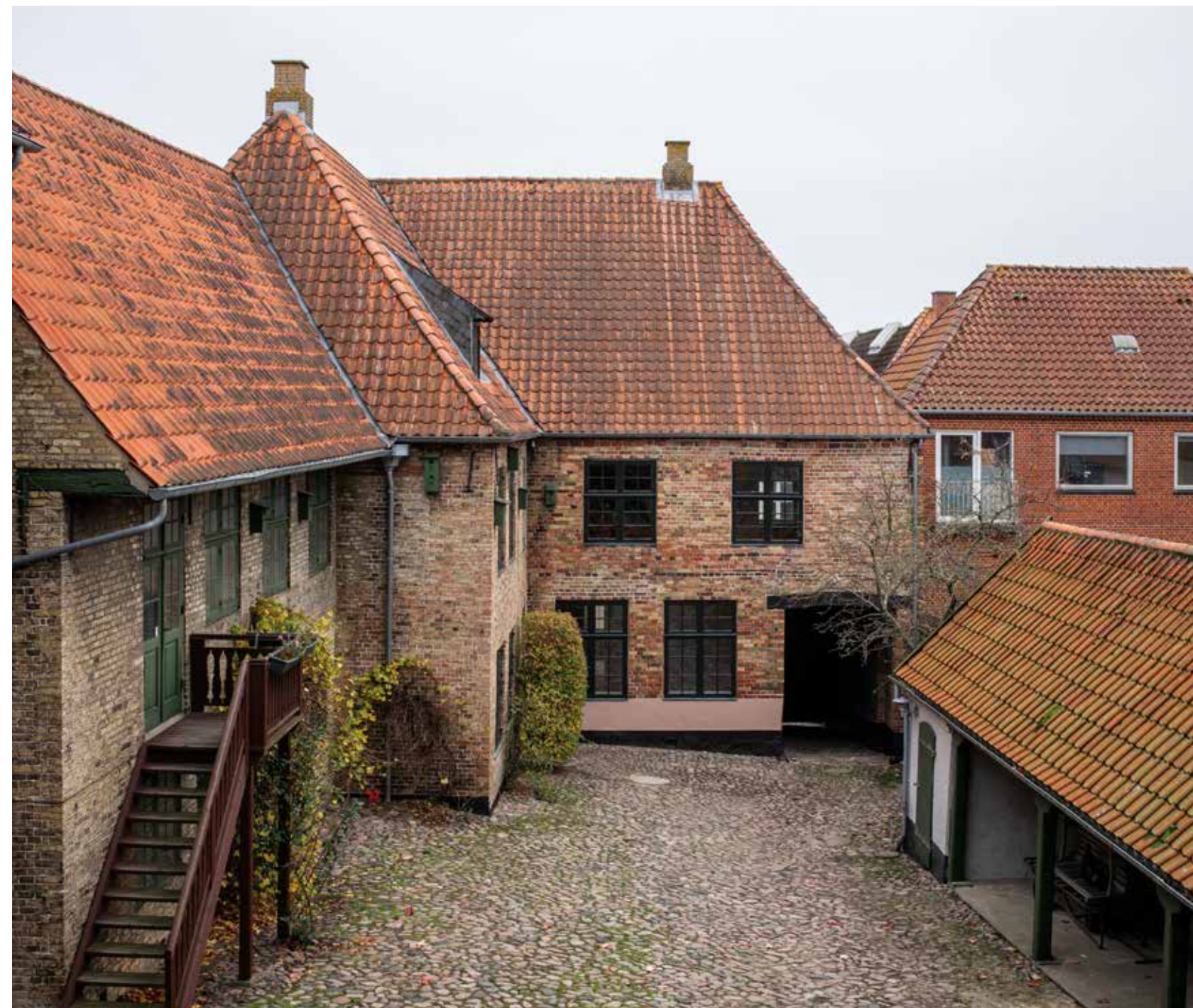
Forhuset [opført 1723] er sammenbygget med det første sidehus [1740], som senere er sammenbygget med det andet sidehus [1744]. Til højre ses et overdækket cykelskur.
