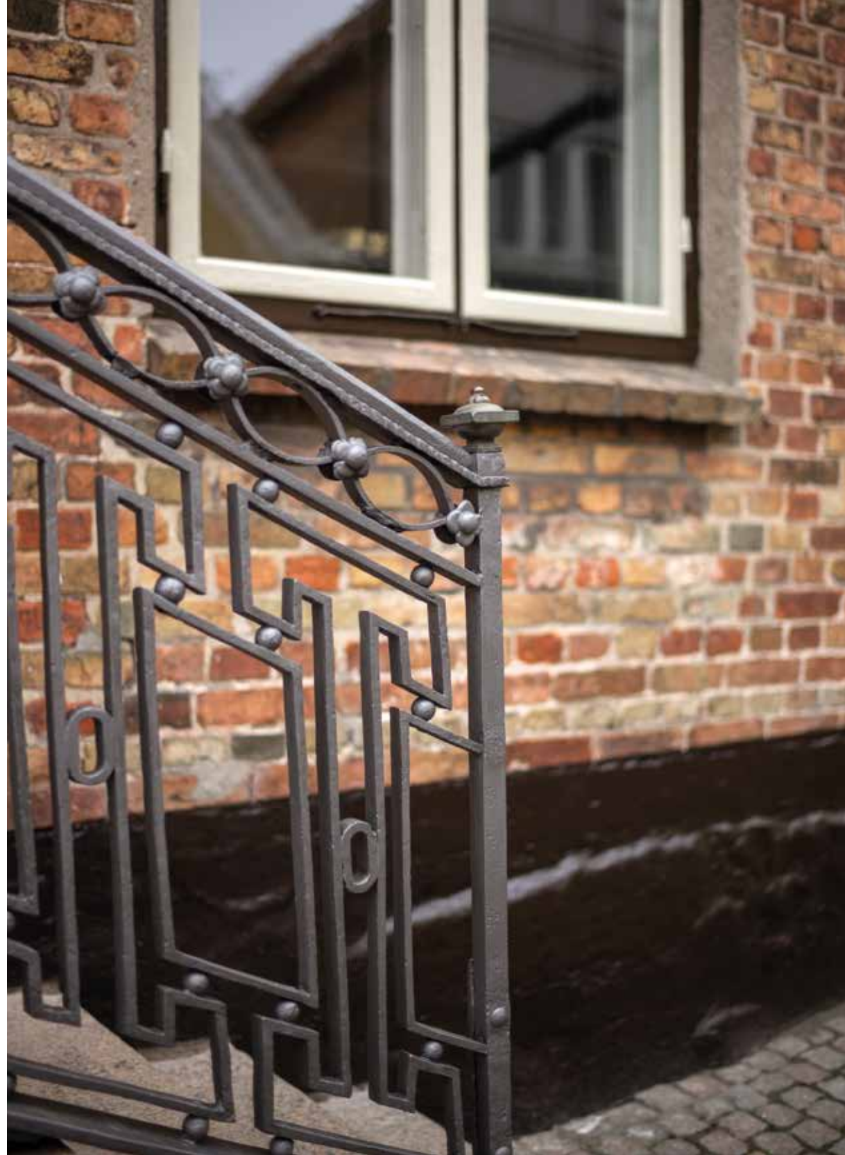
Forhusets vinduer ud til gaden er nymalet i de farver, som blev fundet under den farvearkæologiske undersøgelse: mørk umbrabrun på karmtræ og lys umbrabrun på vinduesrammer.
